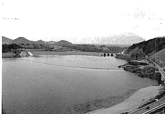
写真－1 満水した御所ダム全景
