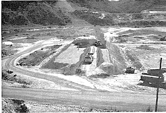
写真-5 スtockパイル盛立状況
