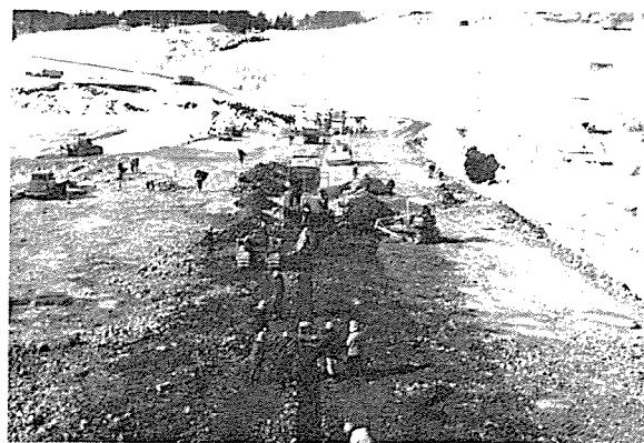
写真-2 アスファルトコア舗設状況
