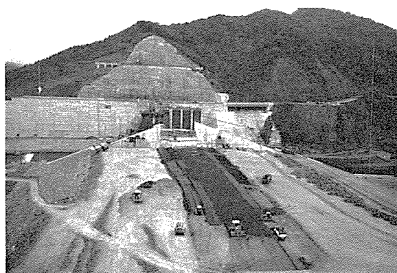
写真-4 盛立施工中のフィル堤体
