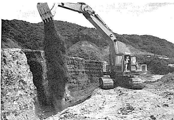
写真-6 バックホーによる混合攪拌状況, 4回程度
