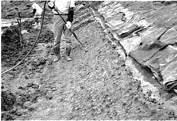
写真-7 左岸泥流層接着面コンタクトコアの施工
