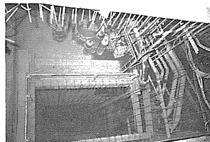
写真-7 垂直パイプ
