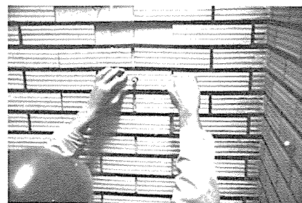
写真-5 タイル取付作業(穴明きタイル廻り)
