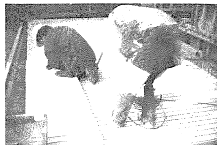
写真-4 セパレーター割付加工
