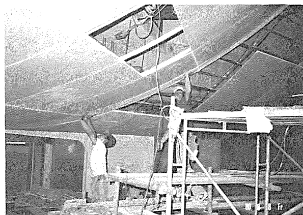
写真-8 礼拝堂曲面天井ボード張り
