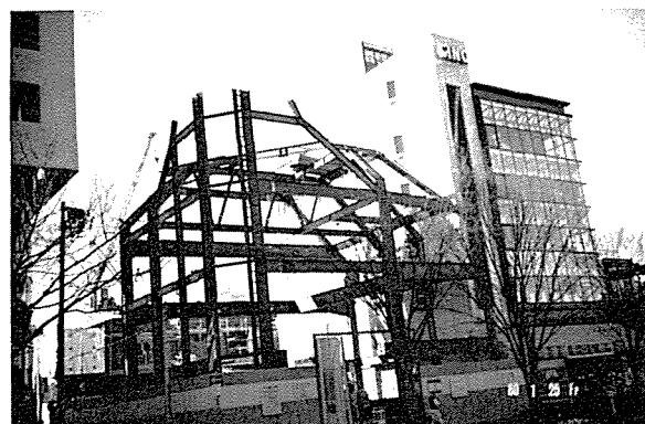
写真-4 鉄骨建方
