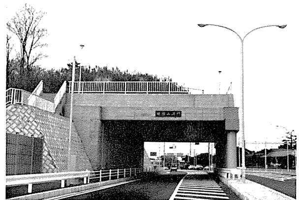
写真-1 完成写真
