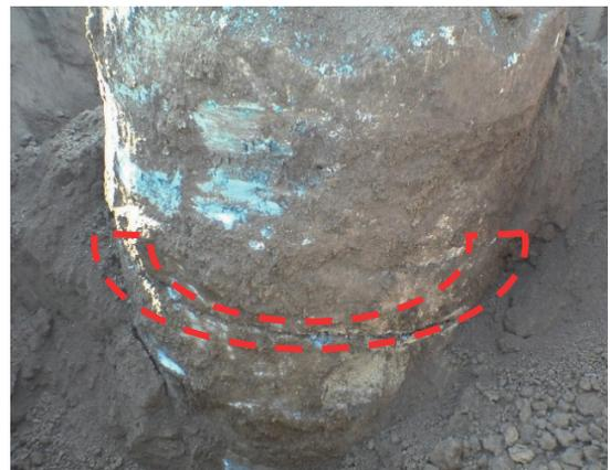
写真-5 水平クラック確認状況
