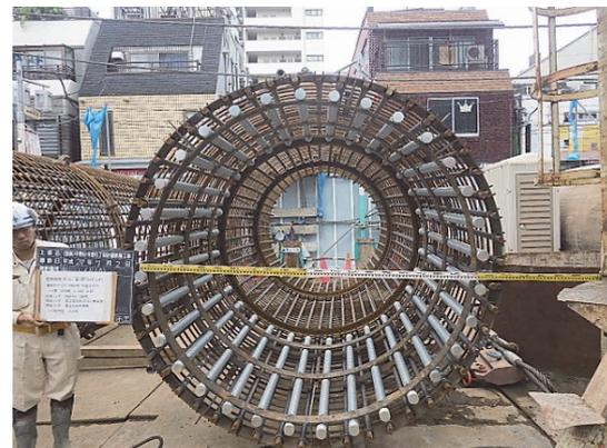
写真-7 鉄筋間隔
