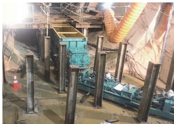
写真-5 圧送ポンプ、シルトミキサー設置状況
