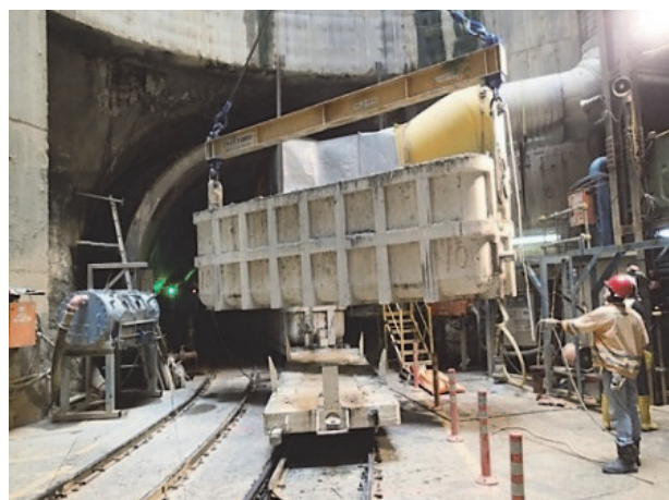
写真－３ 立坑下ズリ函回転状況
