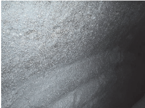
写真－9 切羽状況 坑口～480 m 付近
