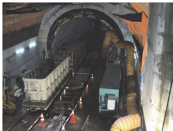
写真-6 拡幅トンネル部土砂圧送設備設置後
