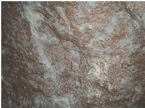
写真－10 切羽状況 坑口～1,600 m 付近
