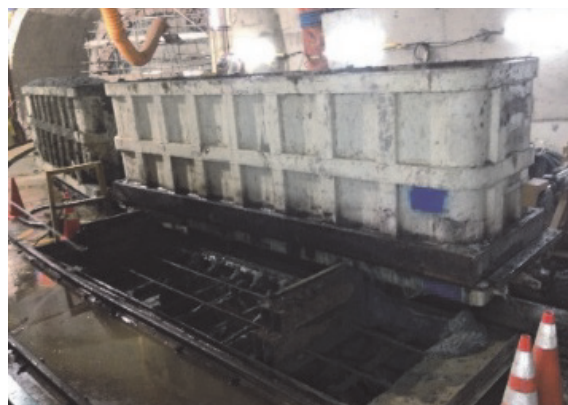
写真-7 スライド式底開きズリ函
