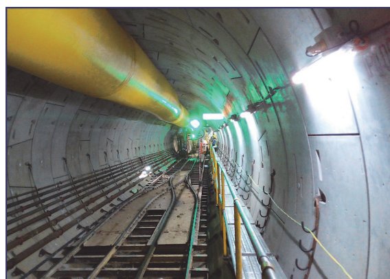
写真-8 軌条設備とYポイント
