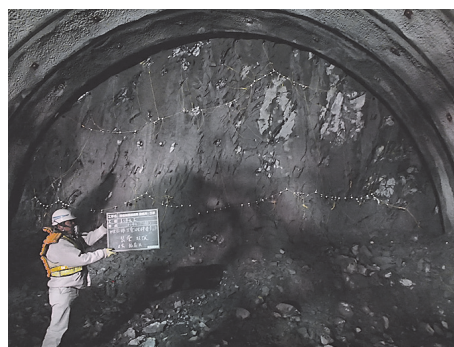
写真－３ 結線状況写真（並列結線）
