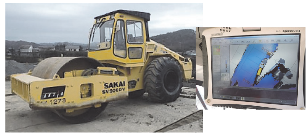
写真-1 GNSS 振動ローラ転圧管理システム
