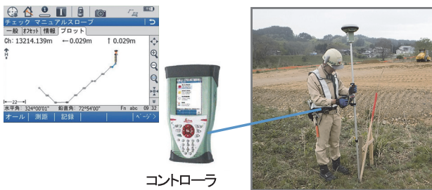
図-5 面的施工管理システムによる測量状況
