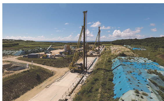
写真-1 施工状況全景
