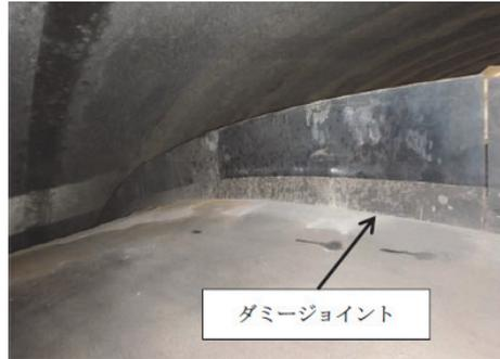
写真-2 鋼板設置対策状況 (対策2)
