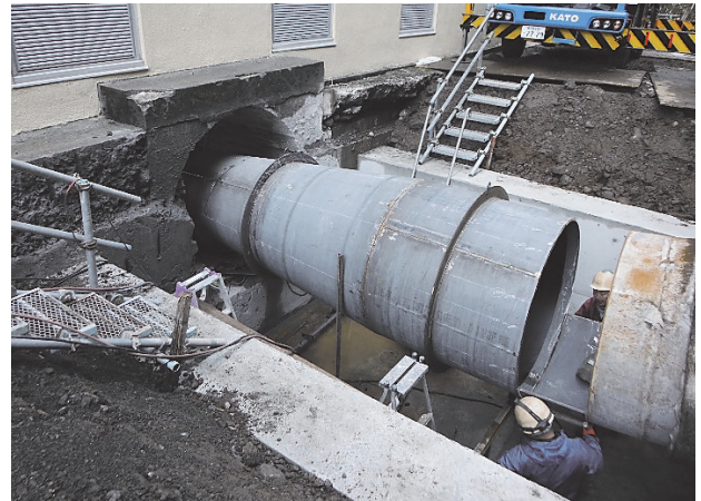
写真-5 新設水圧鉄管設置状況
