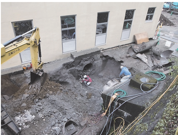
写真-4 既設水圧鉄管除却状況
