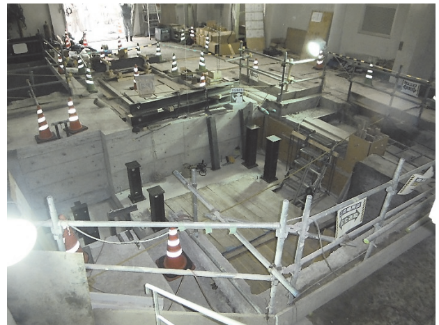
写真-7 ケーシング・吸出し管設置前
