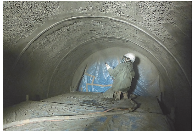
写真-10 放水路内面ライニング状況
