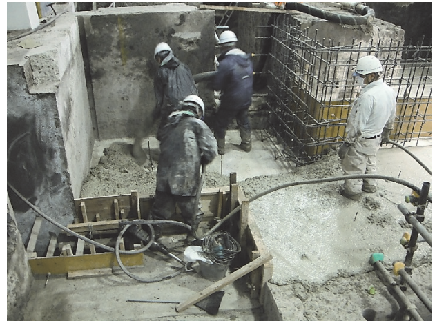
写真-6 水車発電機基礎再構築状況
