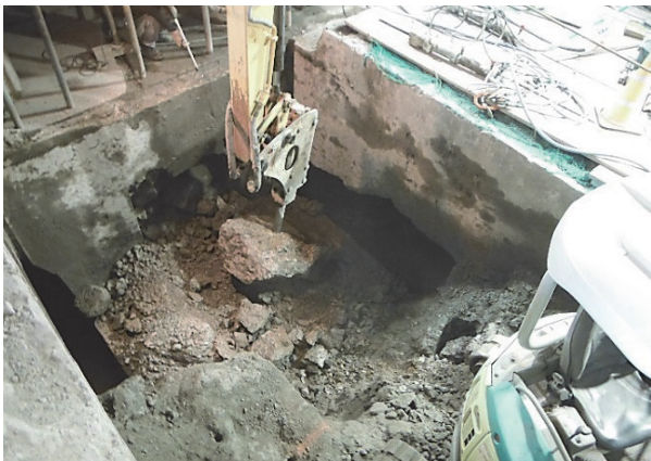
写真-9 放水路隔壁部掘削状況
