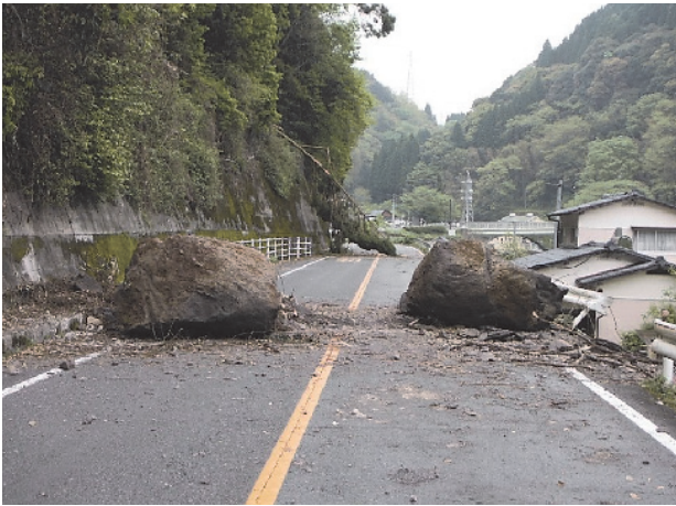
写真-11 周辺道路被災状況（落石）
