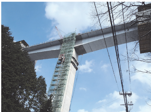
図-7 上部工長期養生
