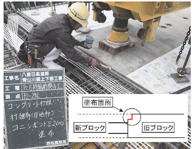
図-4 上部工エポキシ樹脂系接着剤塗布状況
