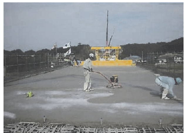
図-5 上部工橋面仕上げ状況
