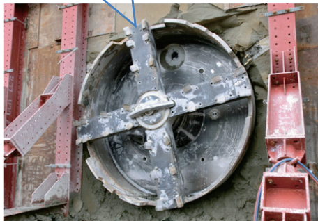
写真-5 シールド到達時ビット状況
