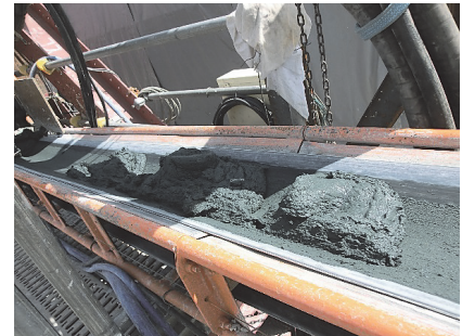
写真-4 排土状況
