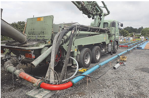
写真-2 ポンプ圧送性試験 (水平換算距離 150 m)
