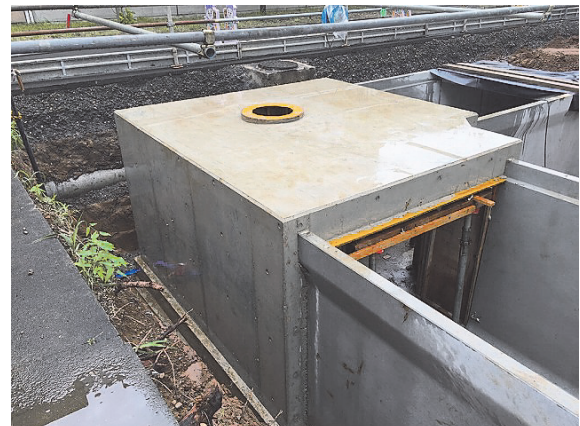
写真-5 型枠脱型後の状況（外観）
