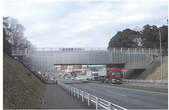
写真-7 施工中の外観
