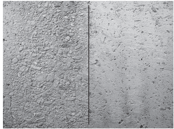
写真-2 コンクリート表面の下地処理例 (左：研削前、右：カップホイール研削後)
