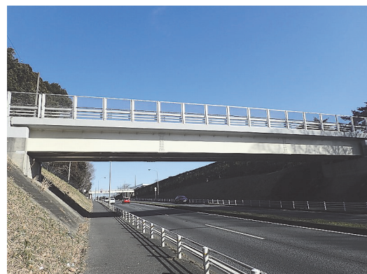
写真-14 補修完了から1年後の状況
