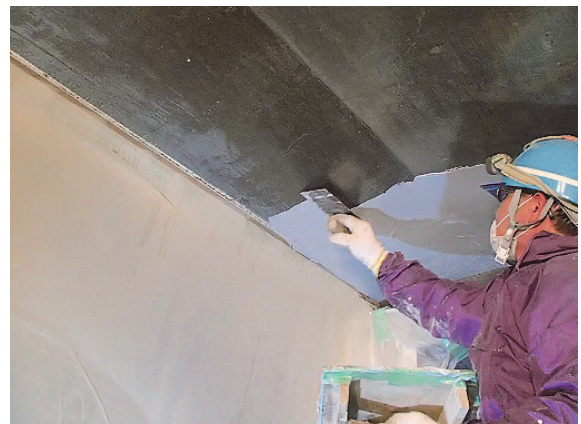
写真-9 接着剤塗布工
