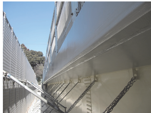
写真-12 施工完了（張出床版下面・地覆側面）
