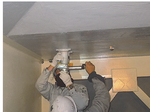
写真-13 現地付着強度試験の状況（床版下面）
