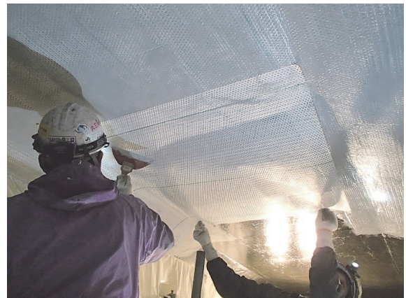
写真-10 繊維シート貼付工
