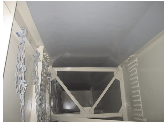
写真-11 施工完了（床版下面（中央部））
