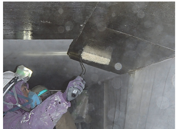
写真-8 プライマー塗布工
