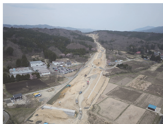
(b) UAV撮影による全景写真
