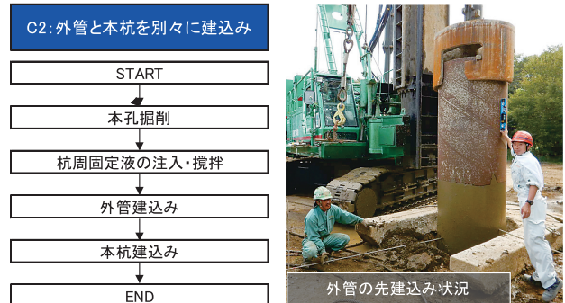
図-10 C2の施工フローおよび施工状況
