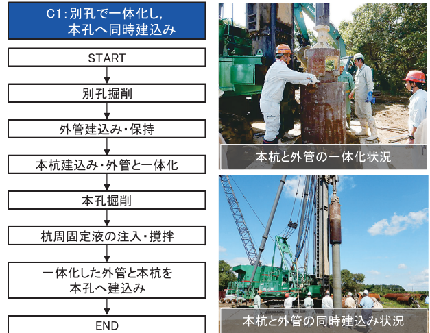
図-9 C1の施工フローおよび施工状況
