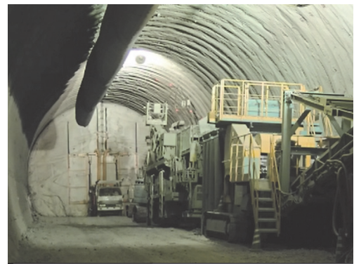
図-5 坑内での使用状況
