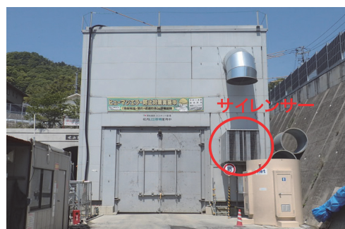
写真－1 防音ハウス
