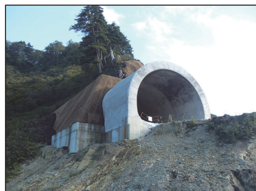
写真-2 トンネル完成
