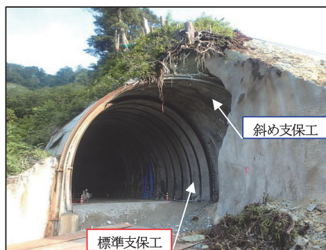
写真-1 越冬前貫通状況
