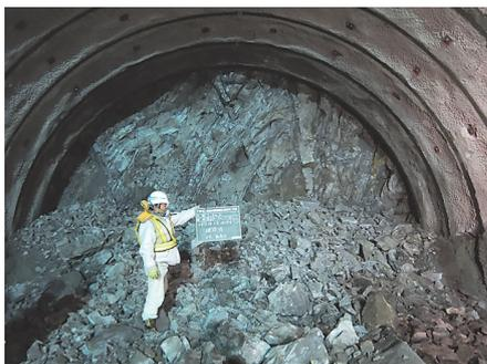
写真-2 非火薬破砕剤による破砕状況
