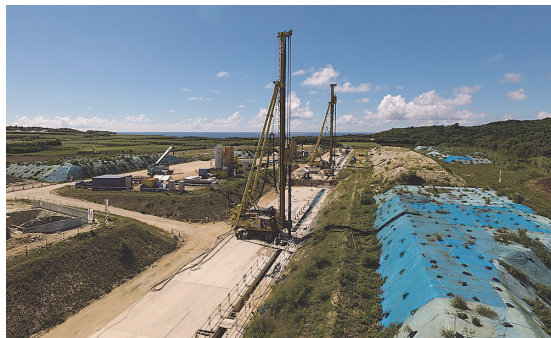
写真-1 地下ダム SMW 止水壁の施工状況
