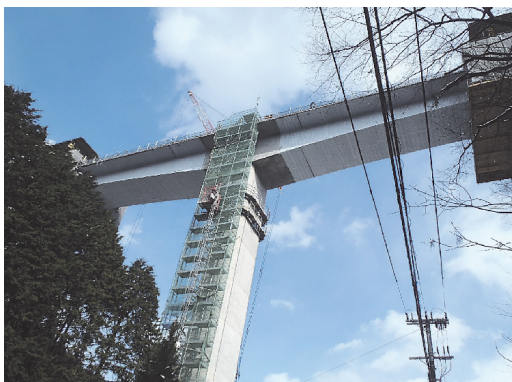
図-3 上部工長期養生
