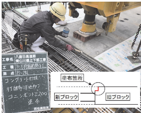
図-1 上部工エポキシ樹脂系接着剤塗布状況
