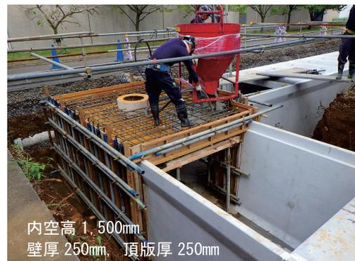
写真-3 共同溝の一部に夏期施工
