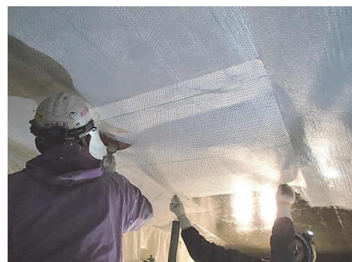
写真-1 施工状況（繊維シート貼付工）
