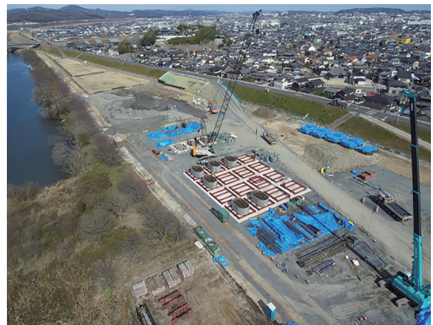
写真一 仮設ヤード全景
