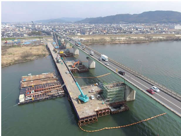
写真一6 施工状況写真 (平成 29 年 3 月)
