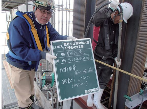
写真-5 鋼管パイプ付きバイブレータ
