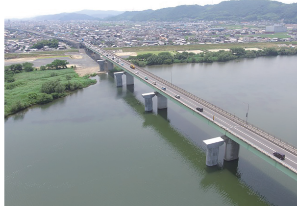
写真一7 工事完成写真 (平成 29 年 6 月)
