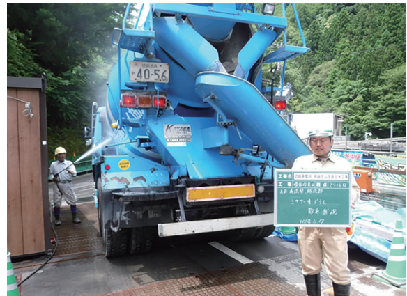
写真-3 生コン車ドラムの冷却
