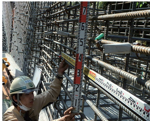
写真-1 ひび割れ補強鉄筋組立状況
