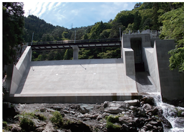
写真一五 ダム改良後
