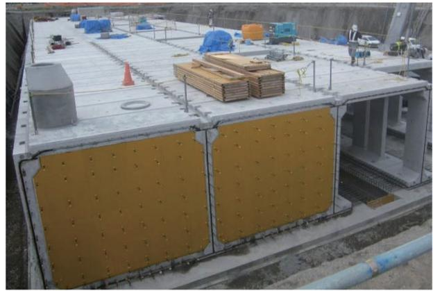
写真二 プレキャスト地下貯留槽 側壁
