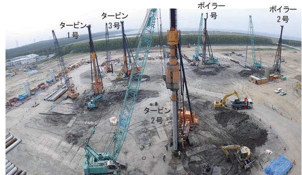
写真-3 杭施工状況
