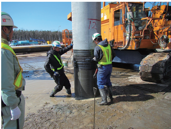
写真一六 機械式継手施工状況
