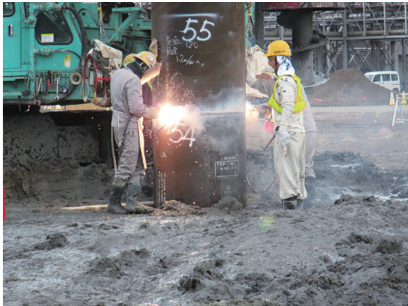
写真一五 溶接継手施工状況
