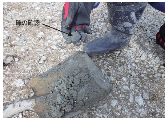
写真一七 支持層の土質確認状況
