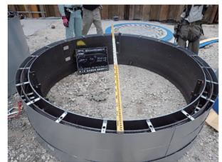
写真一2 型枠の搬入
