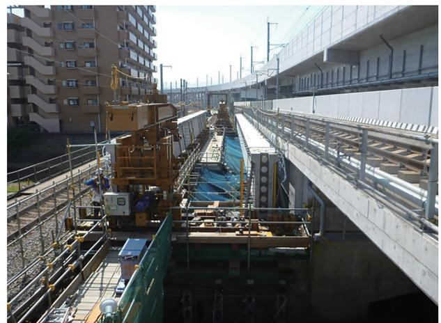
写真-3 主桁横取架設 (横取装置使用)
