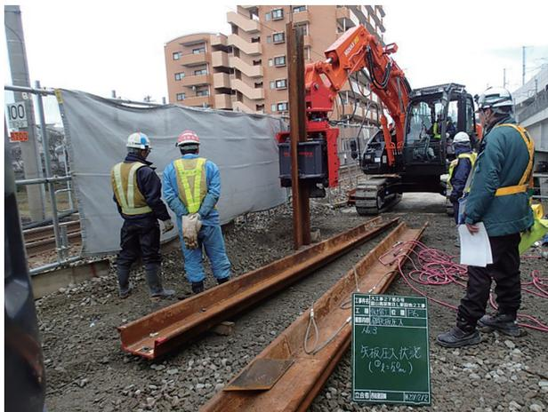
写真-1 P6 橋脚 鋼矢板打設 (MOVAX 工法)
