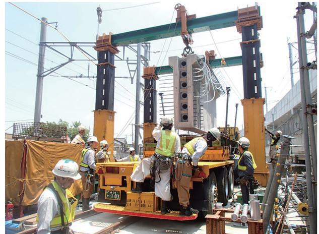
写真-2 桁取卸し (リフター使用)
