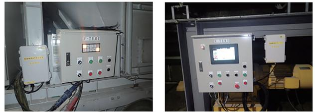
写真-5 換気ファン・集塵機制御機器
