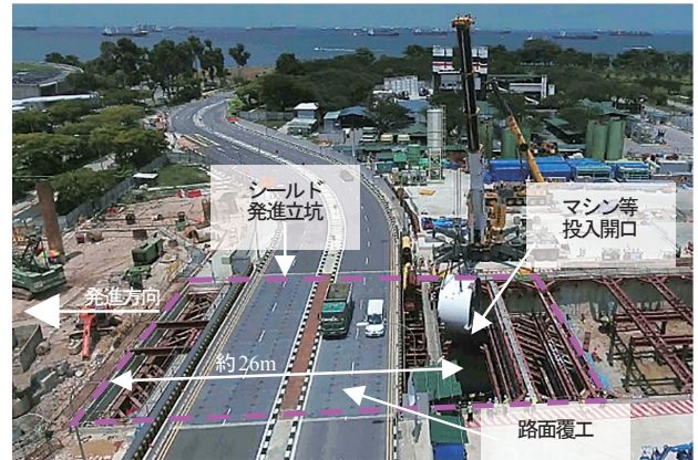
写真-1 シールド中胴投入状況（A 立坑）
