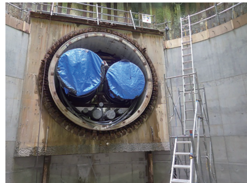
写真一四 本体壁完了時全景
