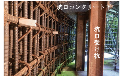
写真一 機械式継手固定用鋼材
