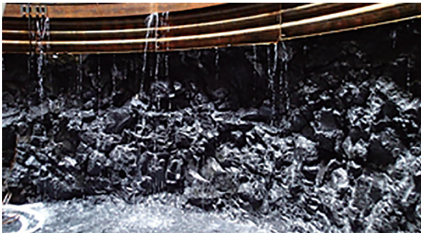
写真一 支持層付近（底版下面）湧水状況
