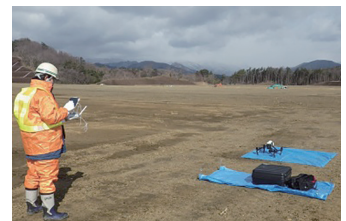
図-1 UAV使用状況
