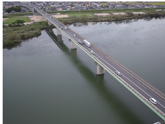
写真-1 着工前全景
