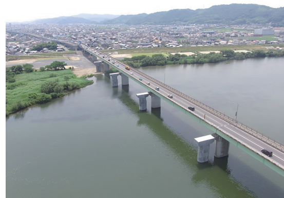
写真-2 完成写真
