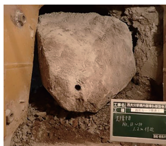
写真-2 ルーフ内支障物
