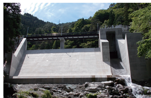
写真-2 ダム改良後
