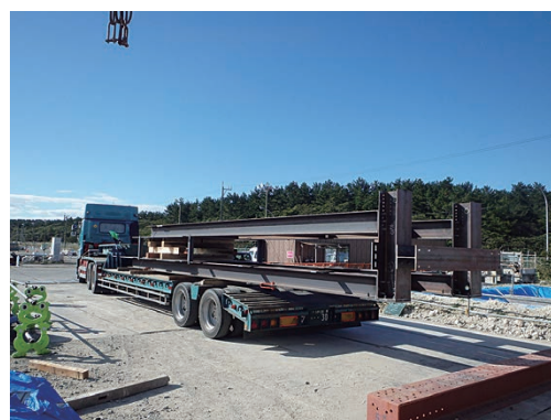
写真―9 波除鋼材蓋全景
