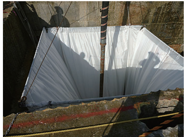
写真—12 袋詰コンクリート打設状況
