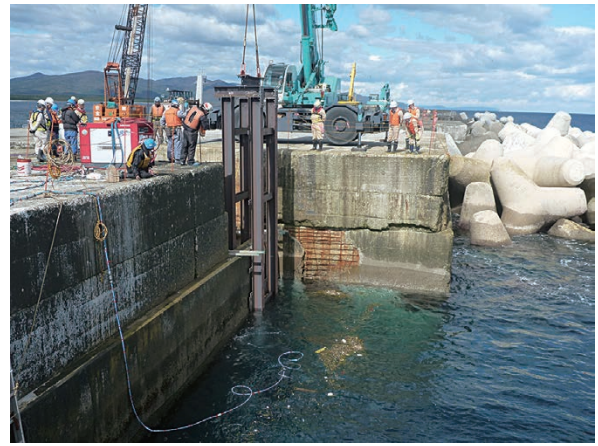
写真一〇 波除鋼材設置状況
