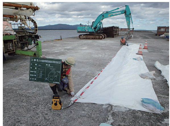
写真一〇 布製型枠全景
