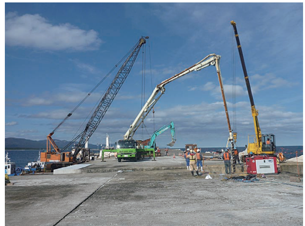
写真—13 打設状況全景
