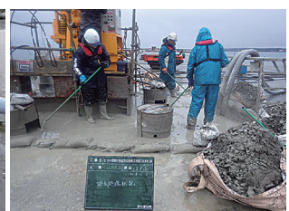
写真-7 ケーソン上での排泥処理
