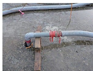
写真-6 バキュームによる直接吸引
