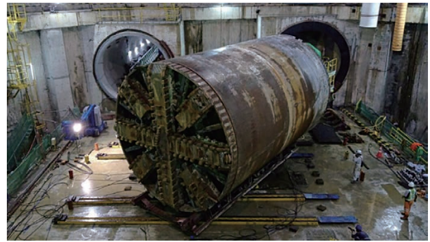
図―12 ターンテーブルによるシールド機回転
