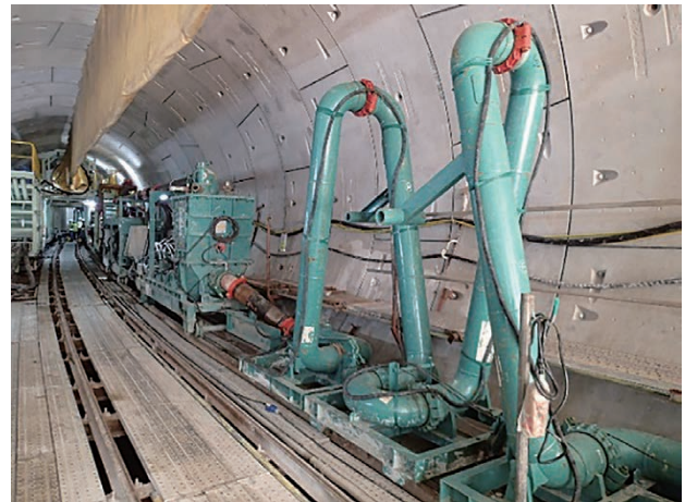
図―13 掘削土砂トンネル全線圧送
