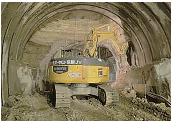
写真二 本坑縫い返し状況（ステップ6）
