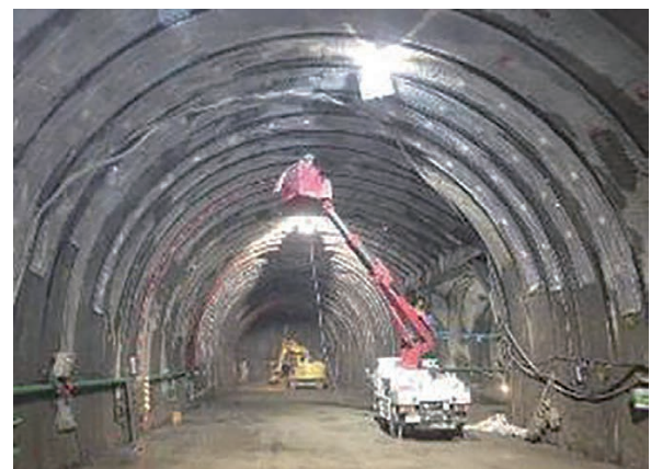
写真三 交差部施工完了状況
