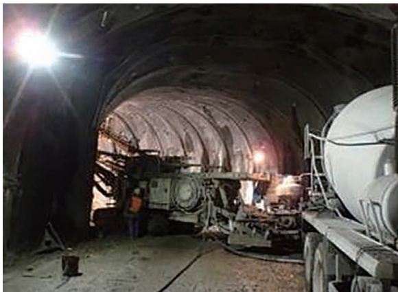
写真一 導坑掘削状況（ステップ2）
