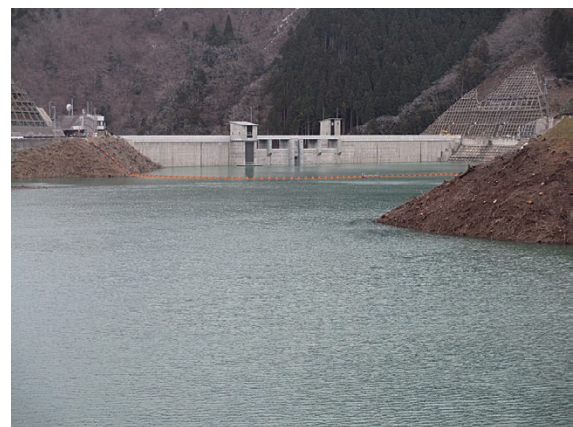
写真-1 上流より試験湛水中の河内川ダムを望む
