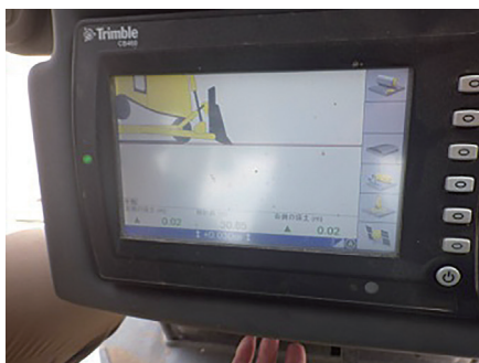
写真-5 ブルドーザー MC オペレーター
