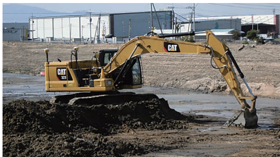
写真一七 バックホウ MG による調整池施工
