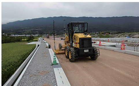
写真一八 モータグレーダ MC による路盤施工
