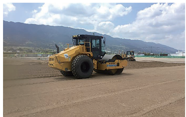
写真-6 GNSS 振動ローラ転圧管理
