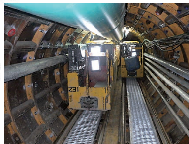
写真-3 坑内離合状況
