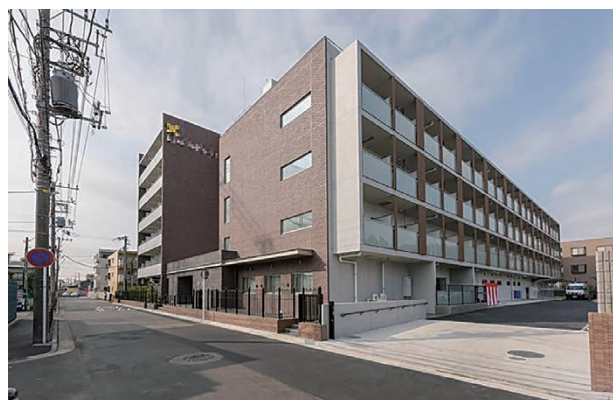
写真－2 日吉寮 外観
