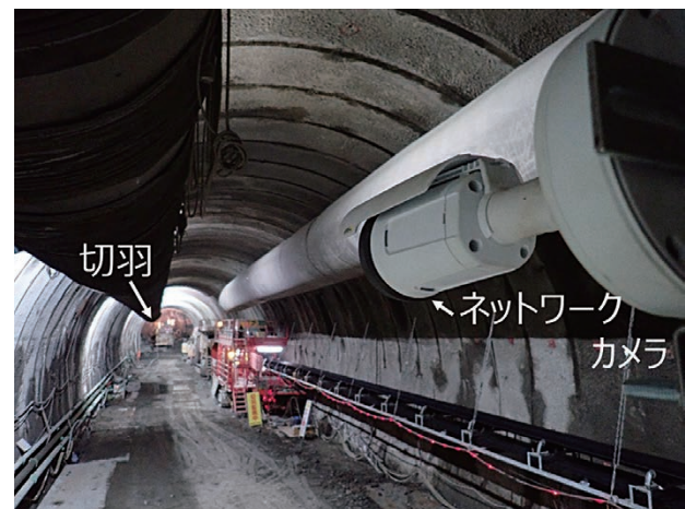
写真-1 ネットワークカメラ設置の様子
