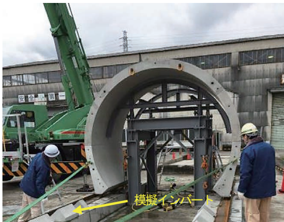
写真-7 模擬覆工の移動
