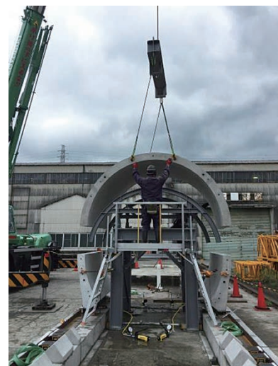
写真一5 組立て架台による組立て
