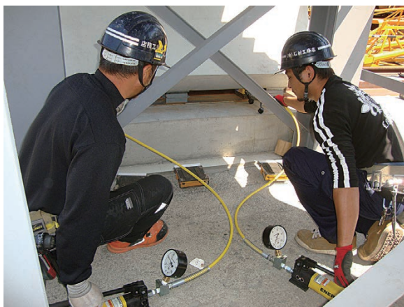
写真-8 小型ジャッキによる盛替え
