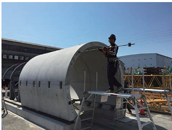
写真-9 PC 鋼棒による接合
