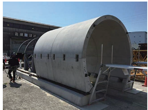
写真-10 設置完了
