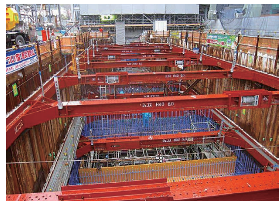
写真一1 施工状況(ポンプ場建屋)
